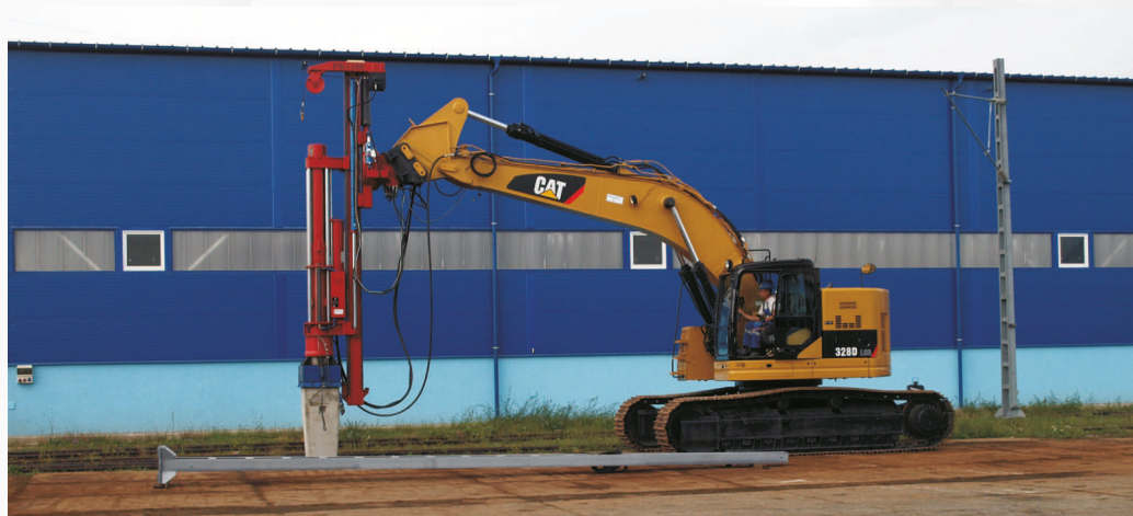
Nabíjanie pilót na železnici
