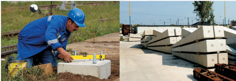
Osádzanie svorníkov, stavebné pilóty
